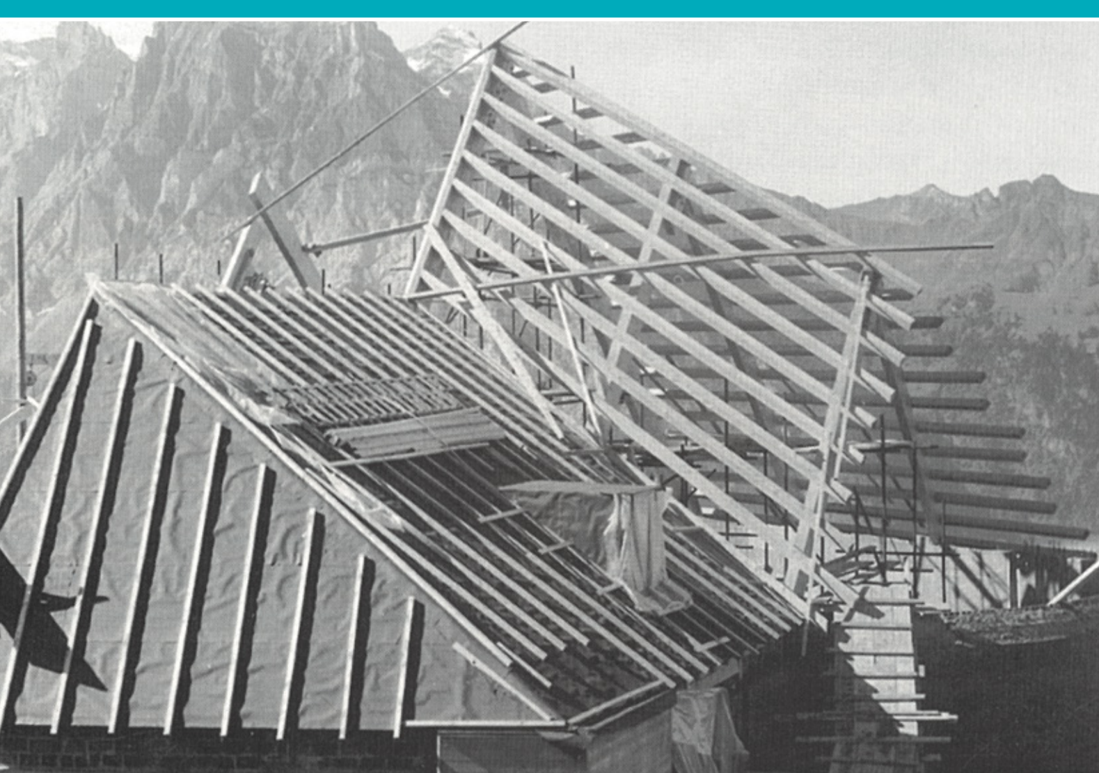
1968 Marienkapelle während dem Bau 10
