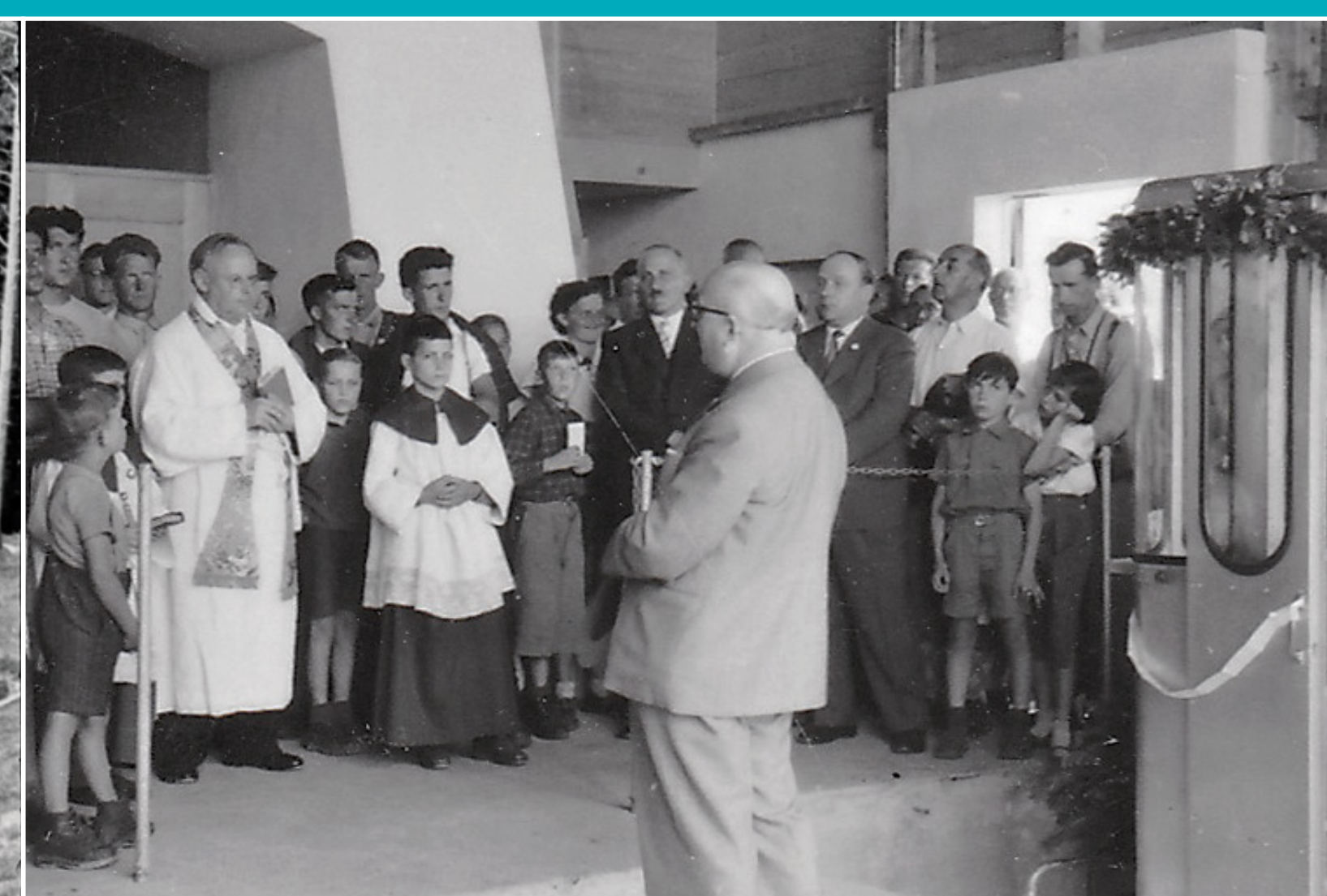
Eröffnungszereemonie der Luftseilbahn bei der Bergstation 1955 14
