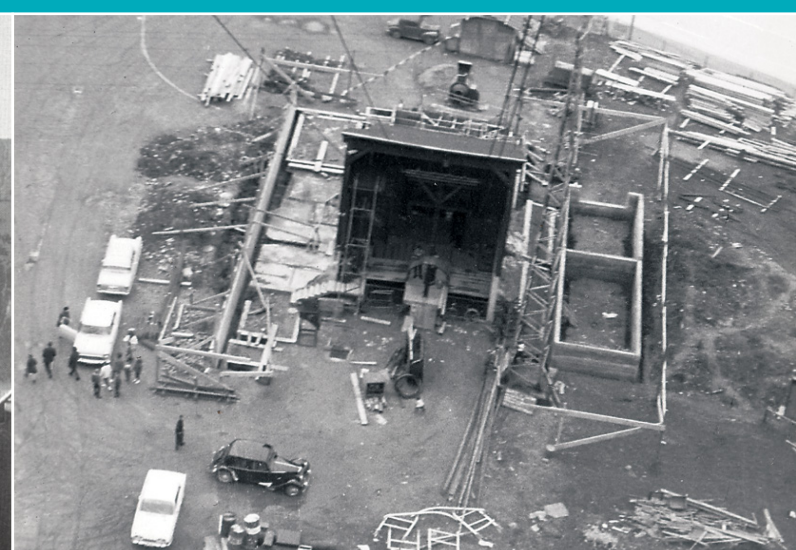
Luftseilbahn Talstation Baustelle 1954-5 10
